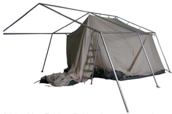
Bild 6: Von Feld zu Feld weiter aufbauen, immer am First beginnend.
