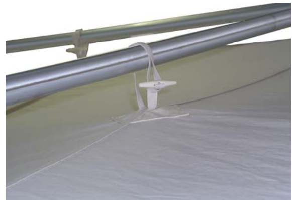
Detail 4: Einhängen in der Dachfläche
