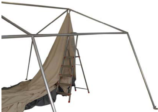
Bild 1: Begonnen wird am Hintergiebel am First.
